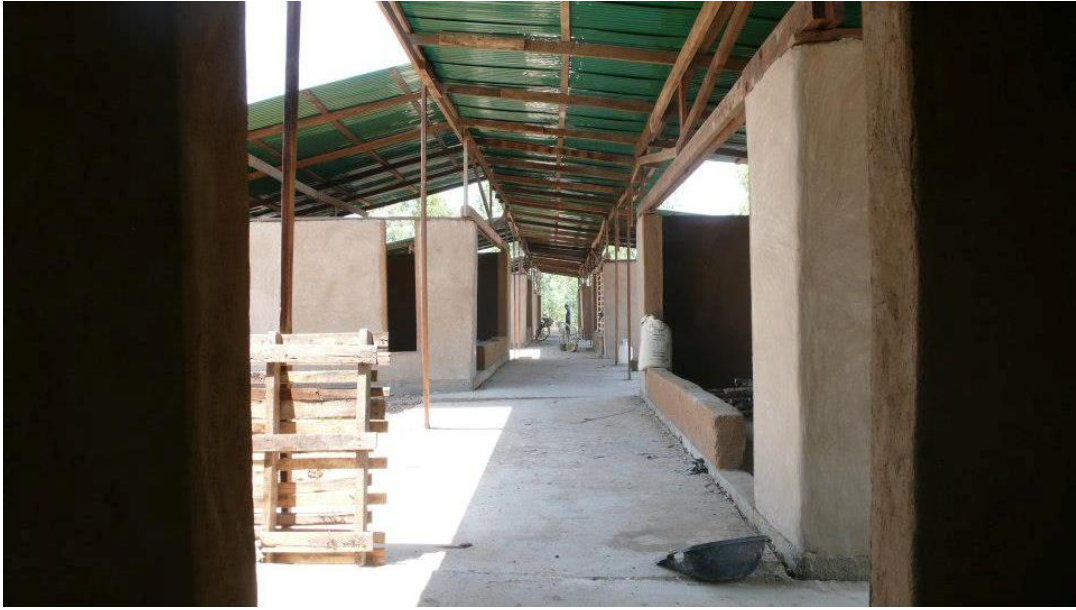
École Kwel Ka Baung en chantier.
